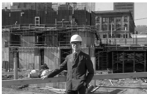
出訪建築工地 (70年代) At job site (1970s)
